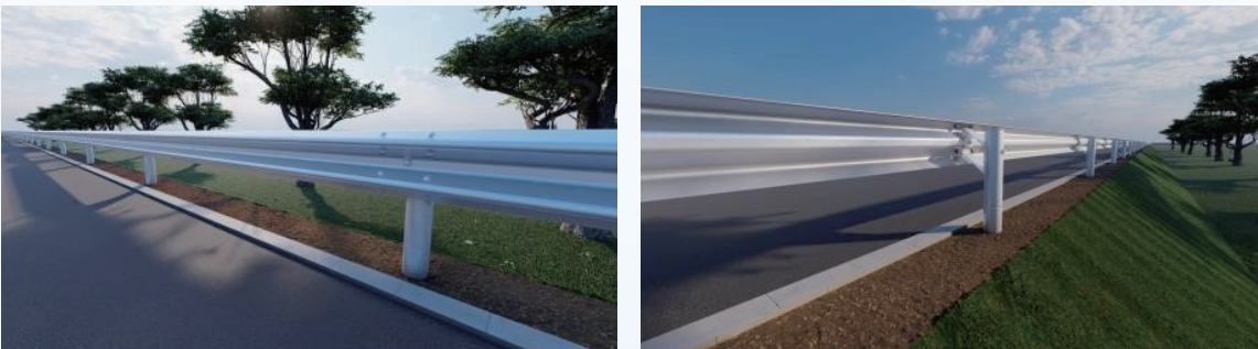
有效高度保持式防阻块改造提升两波形梁护栏
