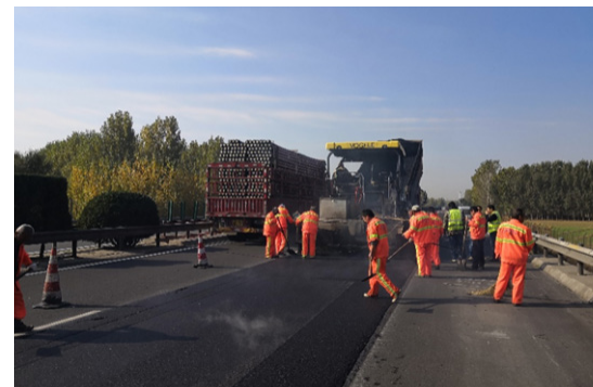
青银高速夏津段超薄磨耗层施工
